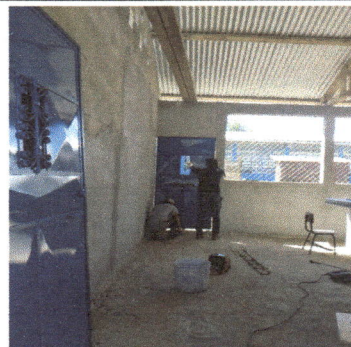
Foto.14. colocación de blocks en muro de mampostería en un módulo de aula.
