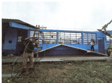
Foto 5. Retiro de instalación eléctrica dañada, en los cuatro módulos de aula.
