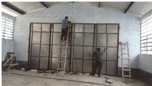
Foto.13. Instalación de paneles divisores metálicos
