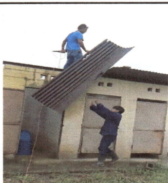
Foto 7. Extracción de láminas acanaladas, del servicio sanitario.
