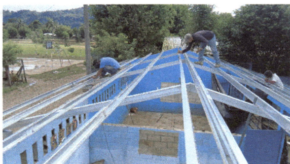
Foto 3. Instalación de estructura metálica, colocación de costaneras, en los tres módulos de aulas.
