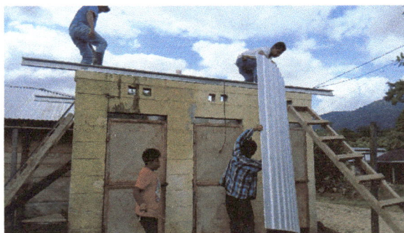
Foto 8. Instalación de cubierta de lámina y estructura metálica en el módulo del servicio sanitario.
