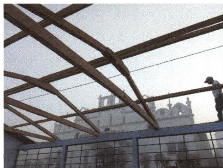
Foto 2: Desmontaje de la estructura de madera que sostenía las láminas acanaladas en los tres módulos de aulas.
