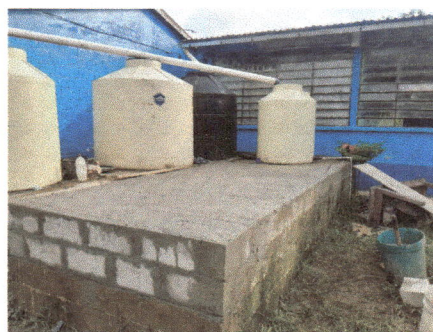
Foto 15: preparación de la plataforma para la instalación del nuevo tinaco.
