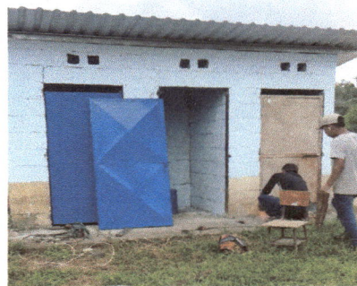
Foto 10: sustitución de puertas metálicas del módulo de servicio sanitario.
