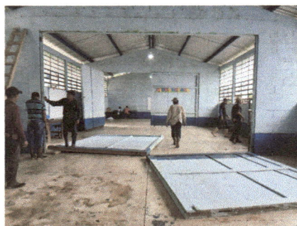
Foto 12. Extracción de los paneles divisores de madera.
