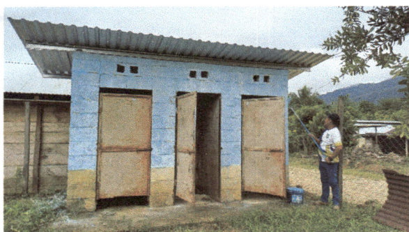
Foto 9. Mantenimiento de pintura en muros interior y exterior del servicio Sanitario.
