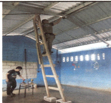
Foto 6: Instalación del sistema eléctrico en los cuatro módulos de aulas.
