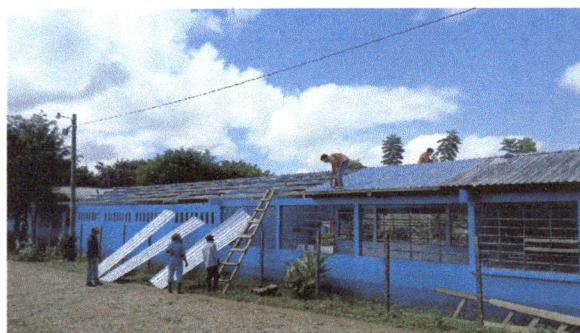
Foto 4. Colocación de cubierta de lámina troquelada en los tres módulos de aulas.
